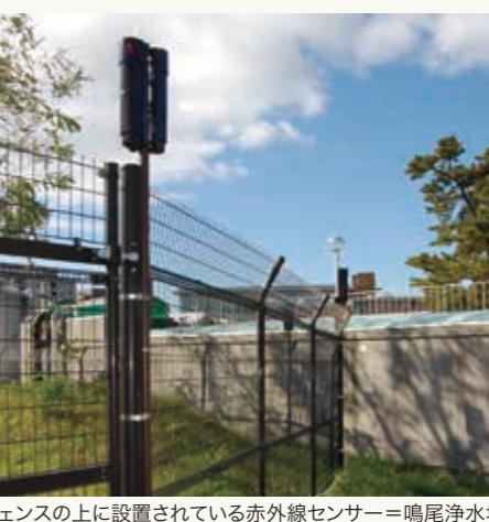
■フェンスの上に設置されている赤外線センサー=鳴尾浄水場
