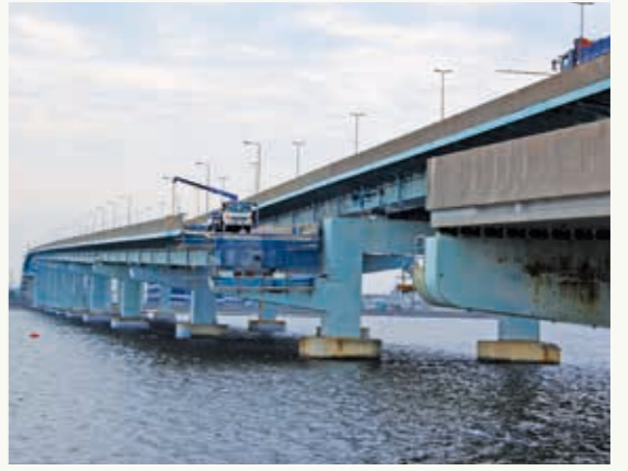
■橋げた架け替え工事の阪神高速5号湾岸線の側道=7月5日、甲子園浜
